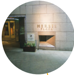
ハービスOSAKA オフィスエントランス
